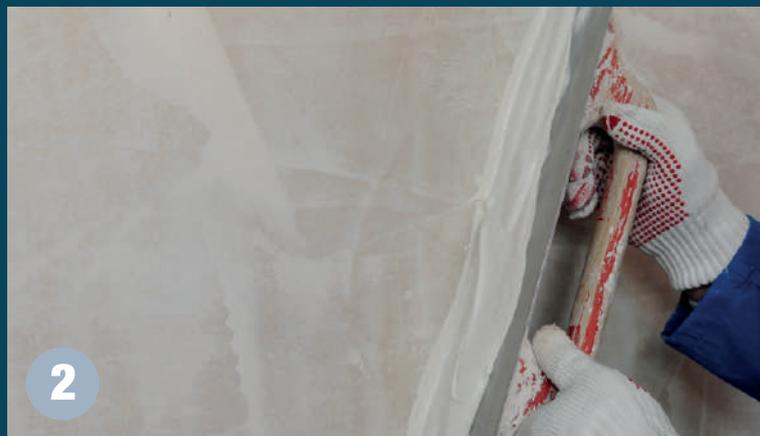
Sitôt après le gâchage, appliquer à la spatule ou à la taloche métallique (lisseuse) en fonction de l'utilisation à laquelle il se destine. Dès que l'enduit devient trop dur ne doit plus être utilisé, ni rallongé avec addition d'eau.
