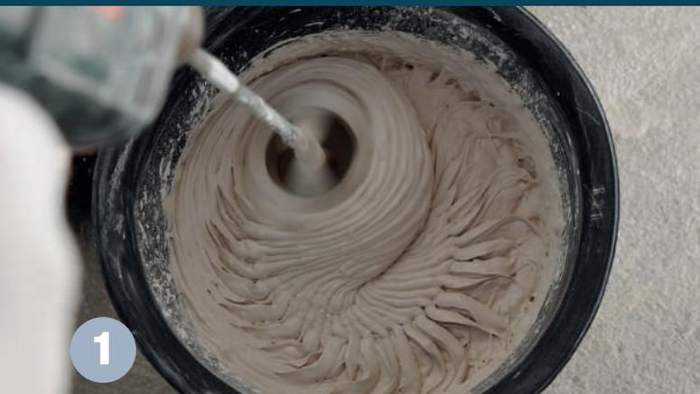
Verser lentement le produit jusqu'à saturation (équivalent à environ 2,2 kg de poudre pour 1 l d'eau) dans un seau propre, contenant de l'eau claire. Laisser reposer 2 à 3 minutes et mélanger avec un malaxeur à hélices jusqu'à l'obtention d'une texture homogène.
